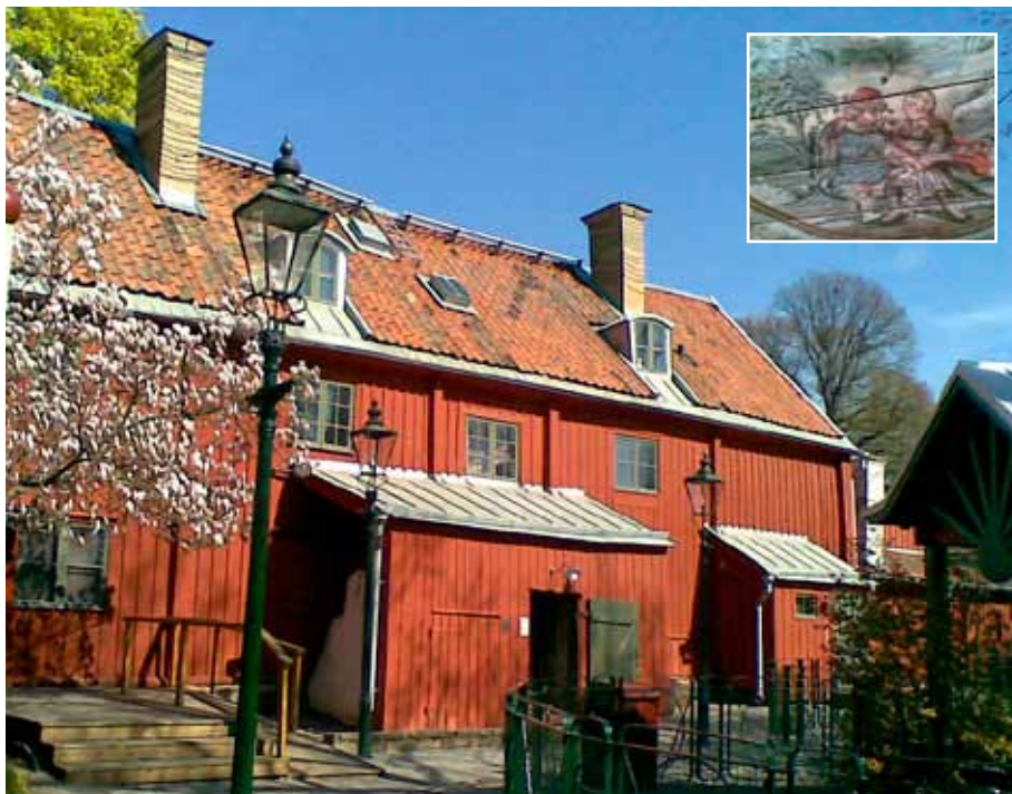
Det blivande Visans Hus är troligen det sista orörda 1700-talshuset i Stockholm. På bilden i nyrestaurerat skick. (Foto: Inger Eklund)
